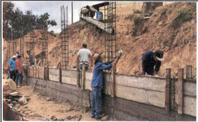
Foto 2: MEJORAMIENTO DEL MURO PERIMETRAL
